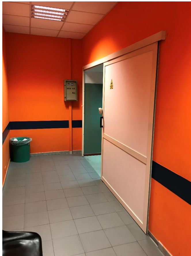
Corridoio locali da ristrutturare
