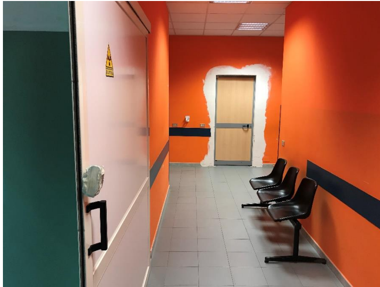
Corridoio locali da ristrutturare
