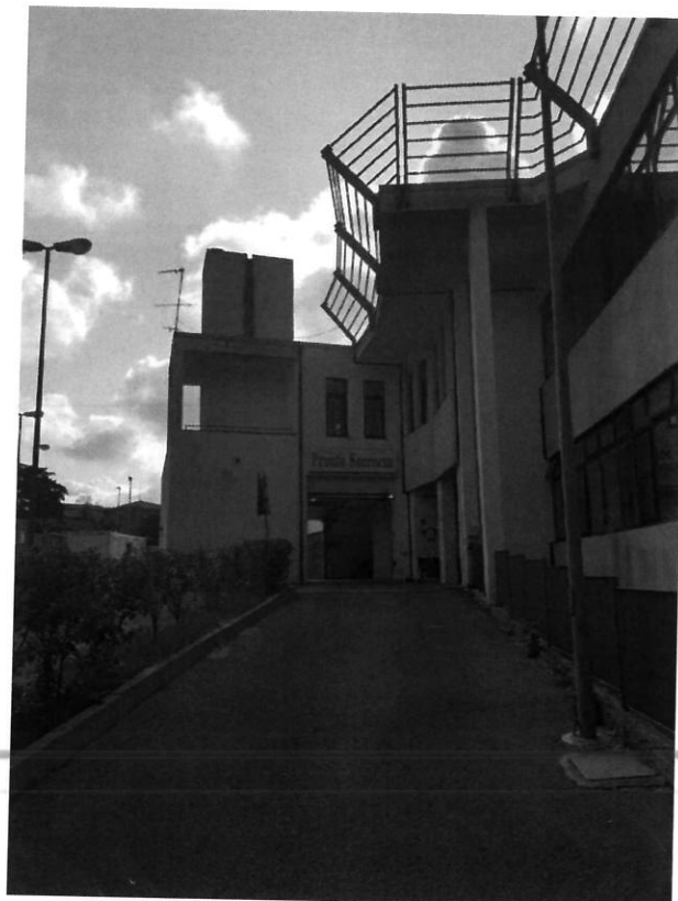
Ingresso pedonale pazienti autosufficienti
